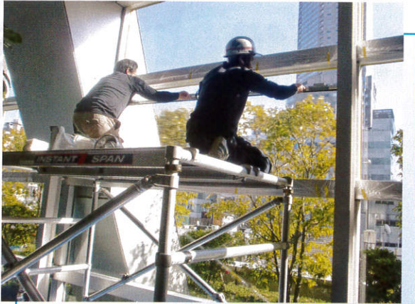
① ワイドガラス施工作業中
