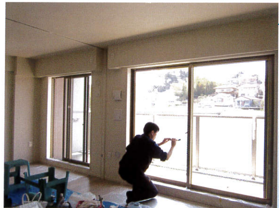
② 一般サイズガラス施工作業中
