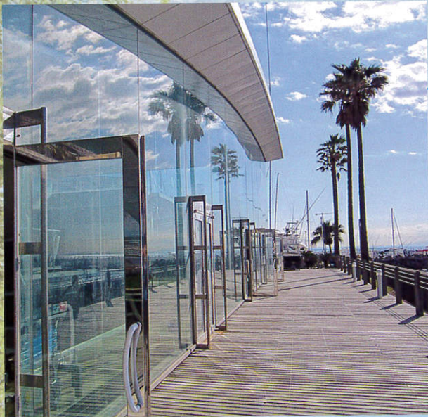
【施工例】リビエラ逗子マリーナ
